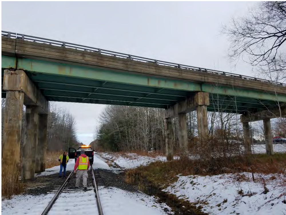
MP 8.99 – Tuttle Rd Bridge
